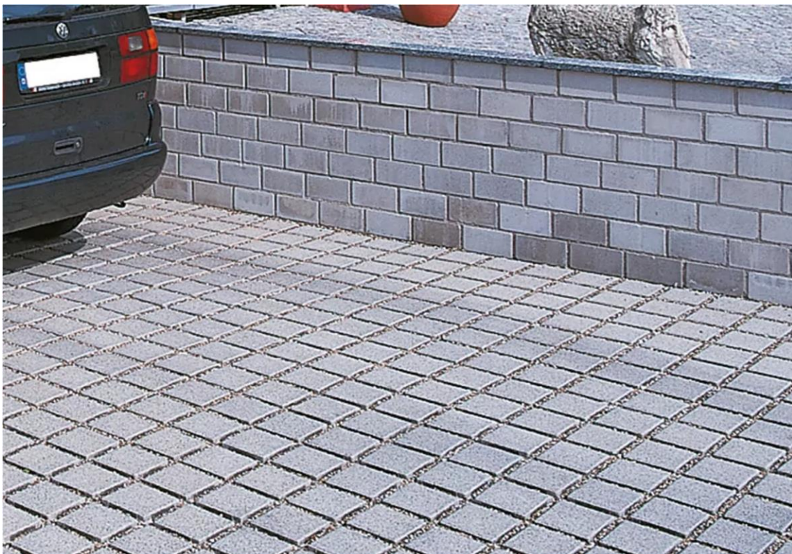
Abb.: Fugenpflaster mit Splitt
